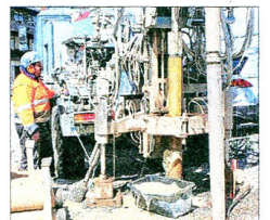
Mit mehreren Bohrungen wurde der Baugrund untersucht. Foto: Stadt Haslach
